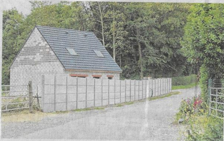
Un palissade qui ne respecte pas le Plan Local d'Urbanisme intercommunal.
