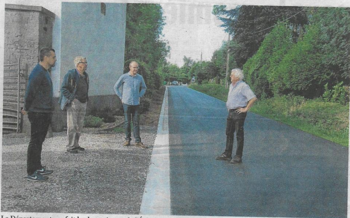
Le Département a refait la chaussée rue de l'Église en enrobé sur plus de 700 m. La commune a pris en charge la borduration sur 200 m.
