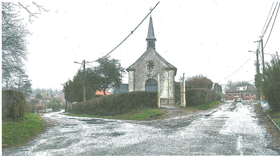
La rue de la Chapelle va avoir une nouvelle borduration et un enrobé neuf.
