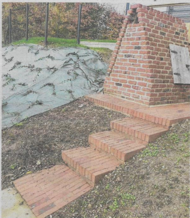
Le puits après restauration.
