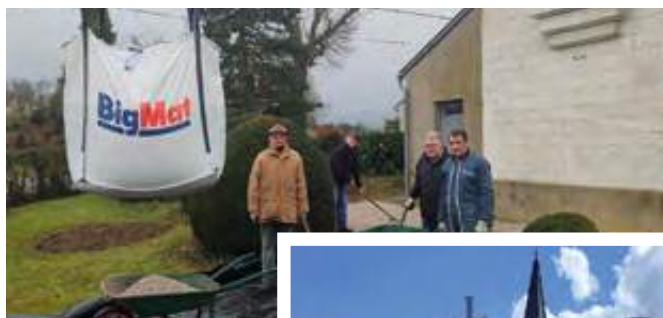
TRAVAUX DERRIÈRE LA CHAPELLE
